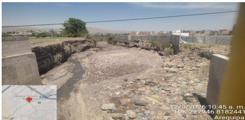
IMAGEN 01: SE OBSERVA LA COLMATACION DEL CAUCE DE LA QUEBRADA LOS INCAS EN EL SECTOR PUENTE ERNESTO GUNTHER MARGEN DERECHA EROSIONADA PERTENECIENTE AL DISTRITO DE AREQUIPA
